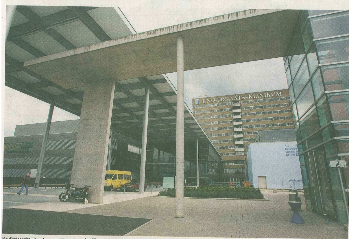
Baufortschritt: Rund um das Haupthaus des Klinikums hat sich schon einiges getan.
