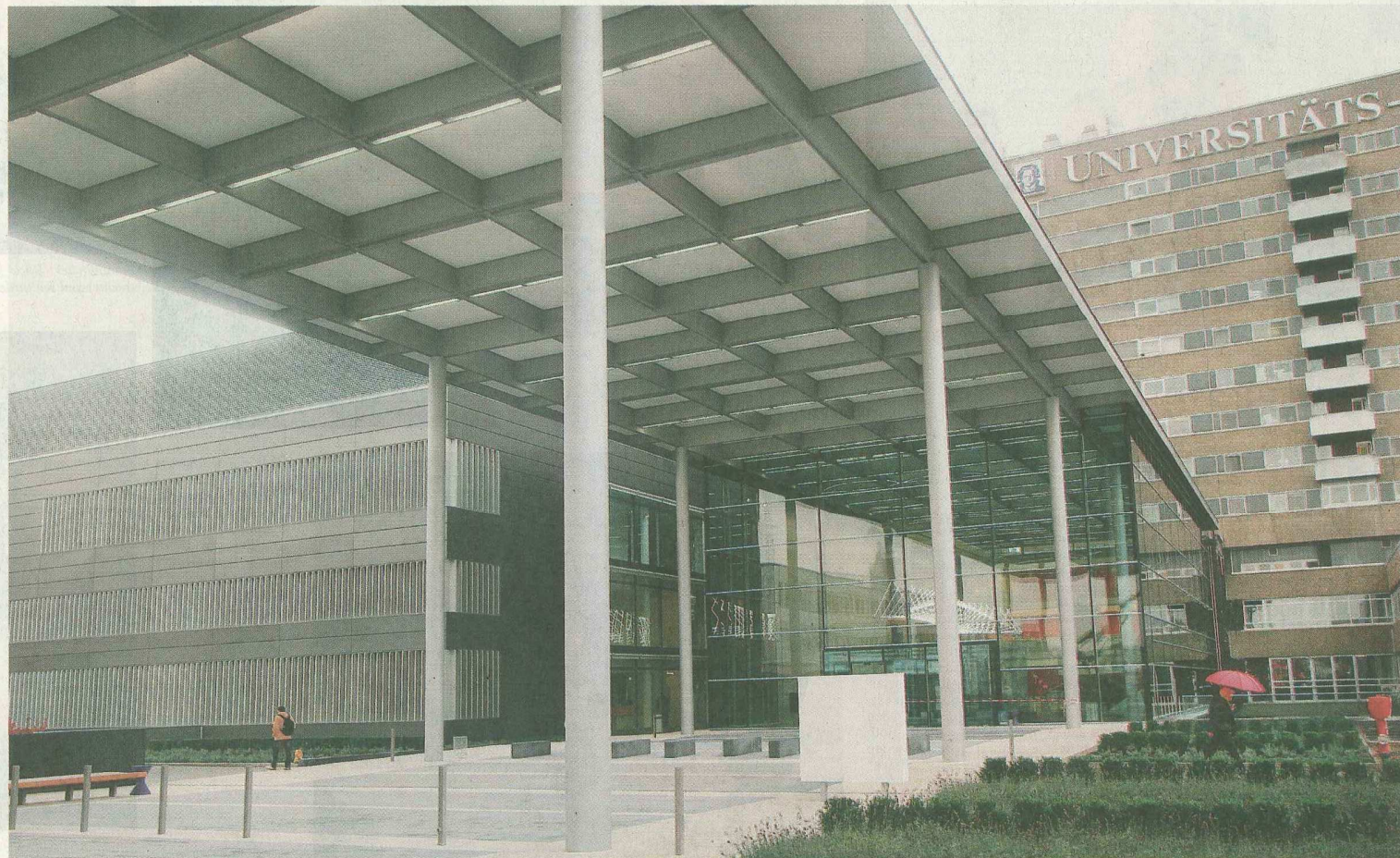
Repräsentativ: Die Eingangshalle des Erweiterungsbaus, in dem alle chirurgischen Fächer und ein neues operatives Zentrum untergebracht sind
